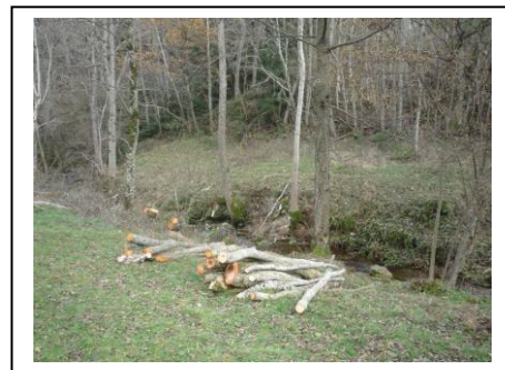
Travaux d'entretien sur le Larzallier à St-Symphorien de Mahun
